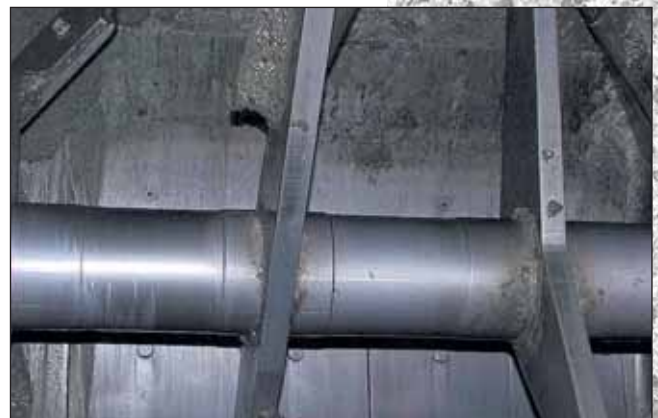
Mischerwelle nach der Reinigung Mixer shaft after cleaning
